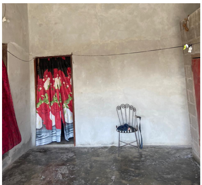
Construcción de piso en vivienda, comunidad El Buen Samaritano.
