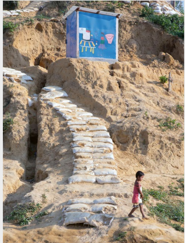
Una letrina en la ladera de una colina en Cox's Bazar, Bangladesh. Se han utilizado sacos de arena para hacer escalones en la colina y para prevenir mayor erosión en un futuro. Las letrinas como estas pueden resultar inaccesibles para las personas que tengan dificultad para subir escalones, incluyendo personas mayores, personas con discapacidad, personas gestantes y niños y niñas pequeños. © Farzana Hossen / British Red Cross
